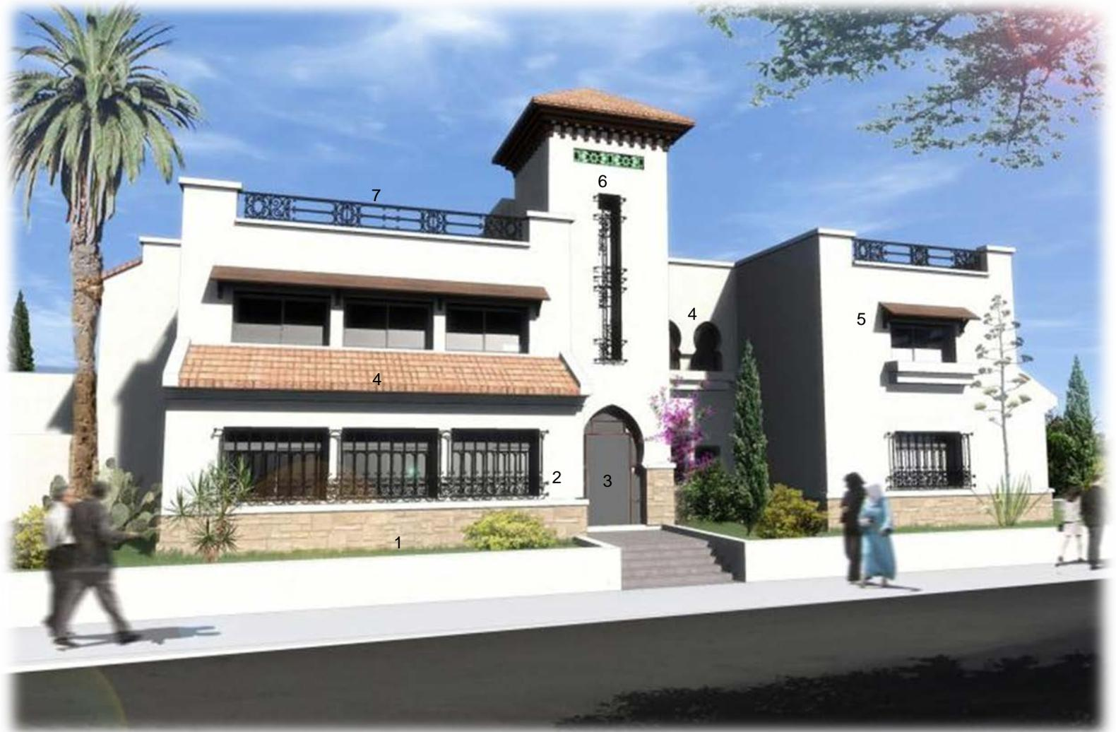
1-Soubassement en pierre/ 2- grille en fer forgé/ 3- Porte d'entrée en arc / 4- Fenêtres en arcades / 5-Protection de fenêtre en bois / 6- Frise en zellige / 7- Garde-corps en fer forgé.
