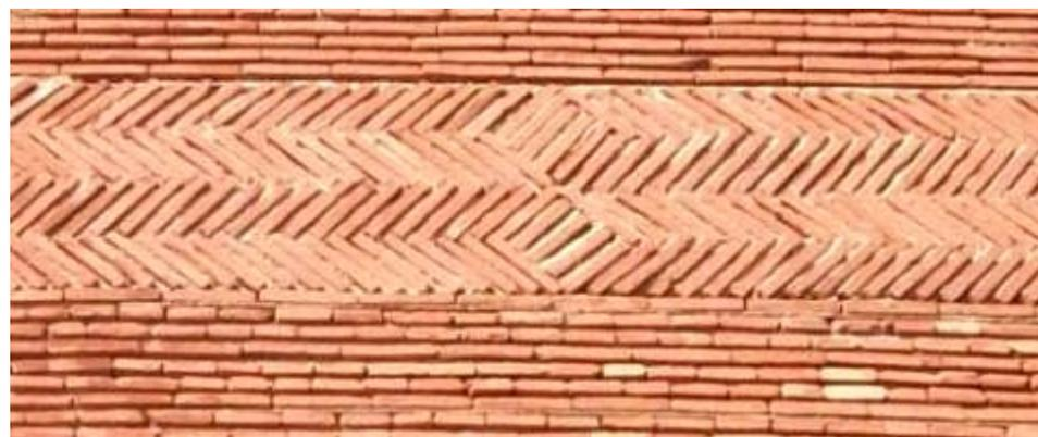
Exemples d'appareillages en brique "massisso"
