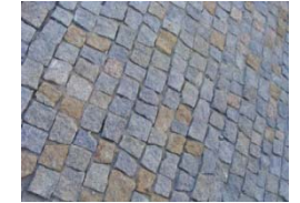
Pavé original en moellon
