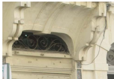
ADRESSE: RUE DE LA LIBERTÉ, N°60
