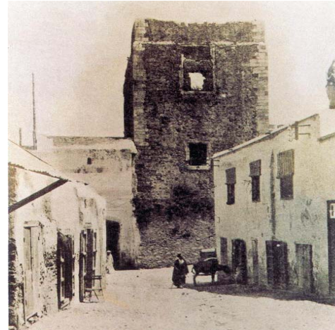
La Tour Al Kamra avant et après la restauration
